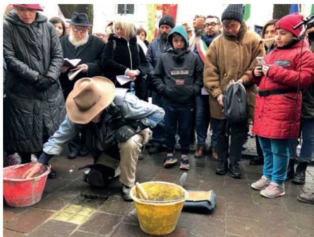
La posa delle lastre da inciampo
